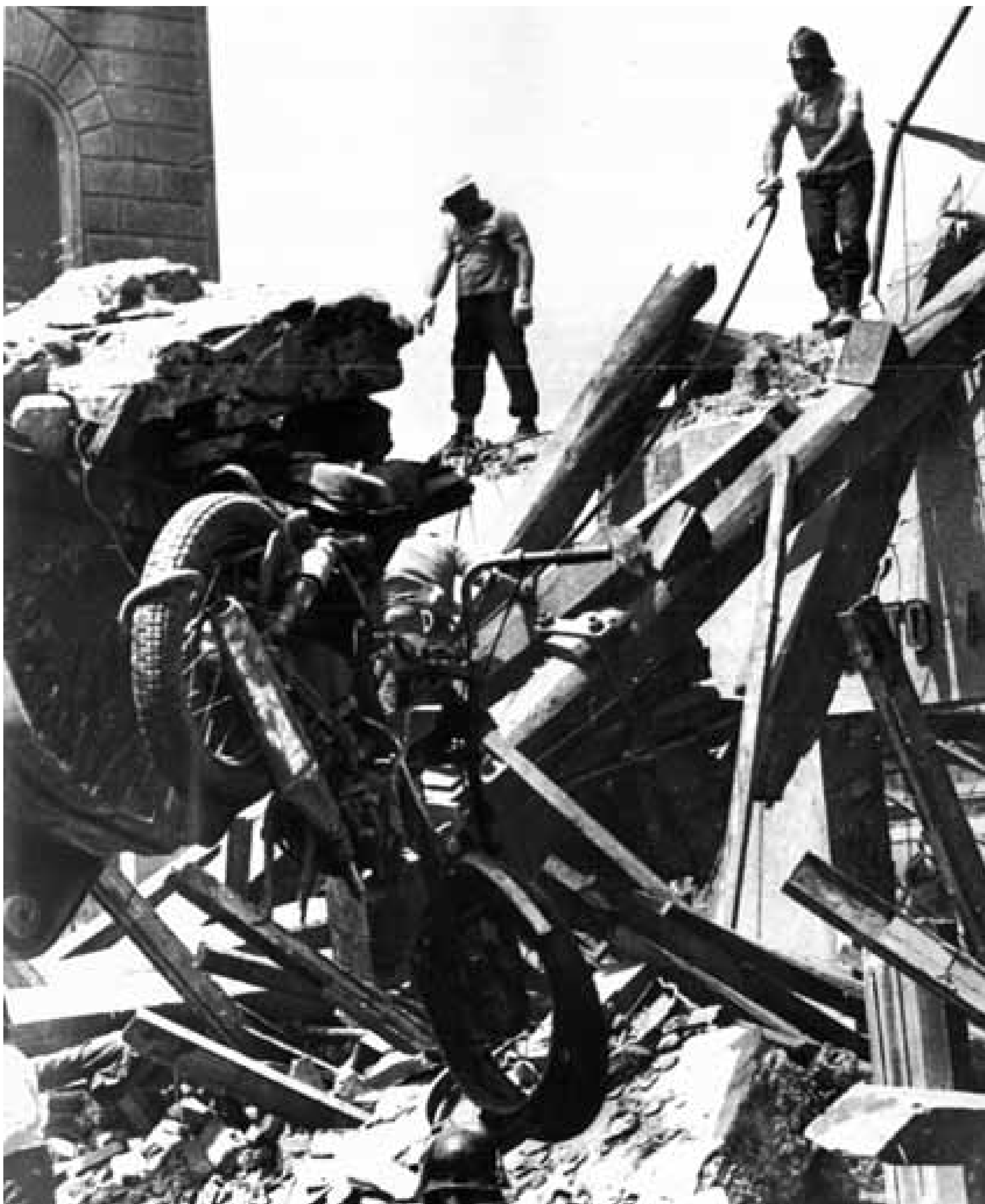
Rimozione delle macerie (foto Comune di Bologna, archivio Associazione 2 Agosto)
