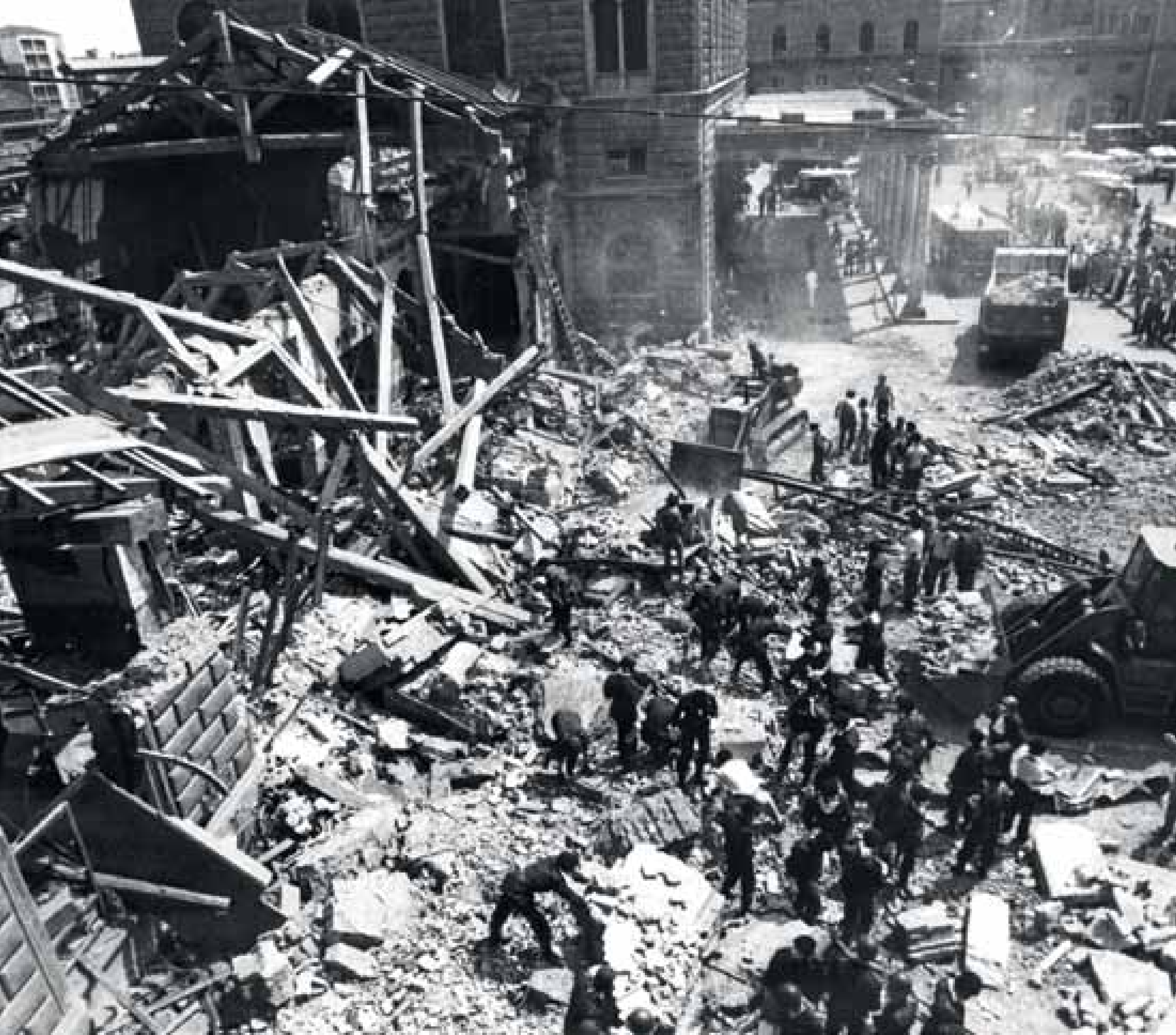
I soccorritori al lavoro sul piazzale della Stazione di Bologna. (foto Gaggioli, archivio Associazione 2 Agosto)
